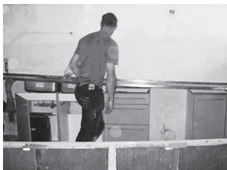
Einbau der neuen Küche.
