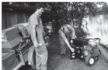
Die neue Schmutzwasserpumpe.
