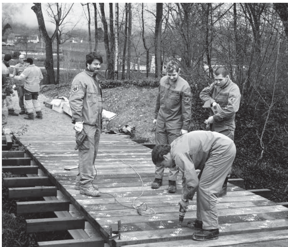
Bau der Dürrbachbrücke.
