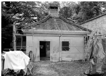
Blumenstein Dach Brunnenhaus.
