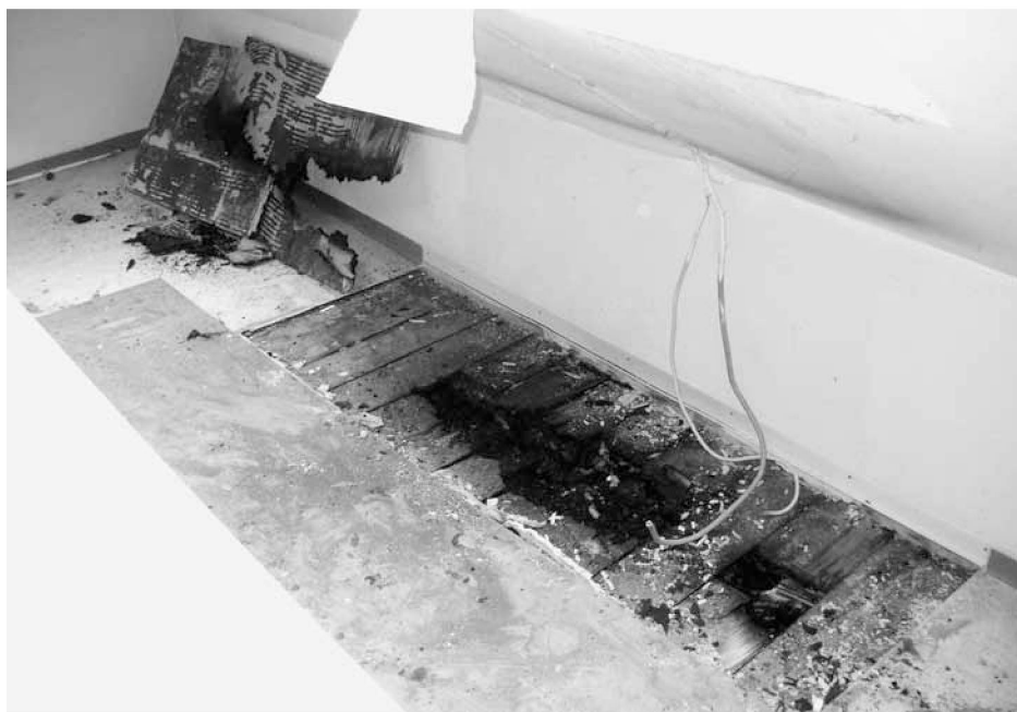
Hitzestau unter Ofen, Schaalgasse.
