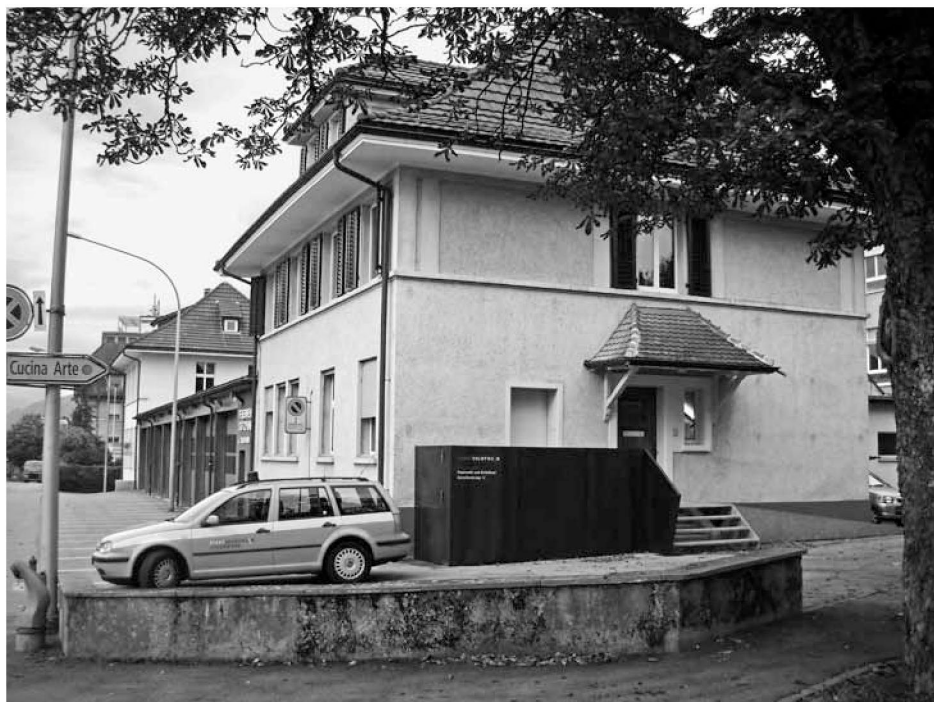
Unser neuer Standort, Grenchenstrasse 12.
