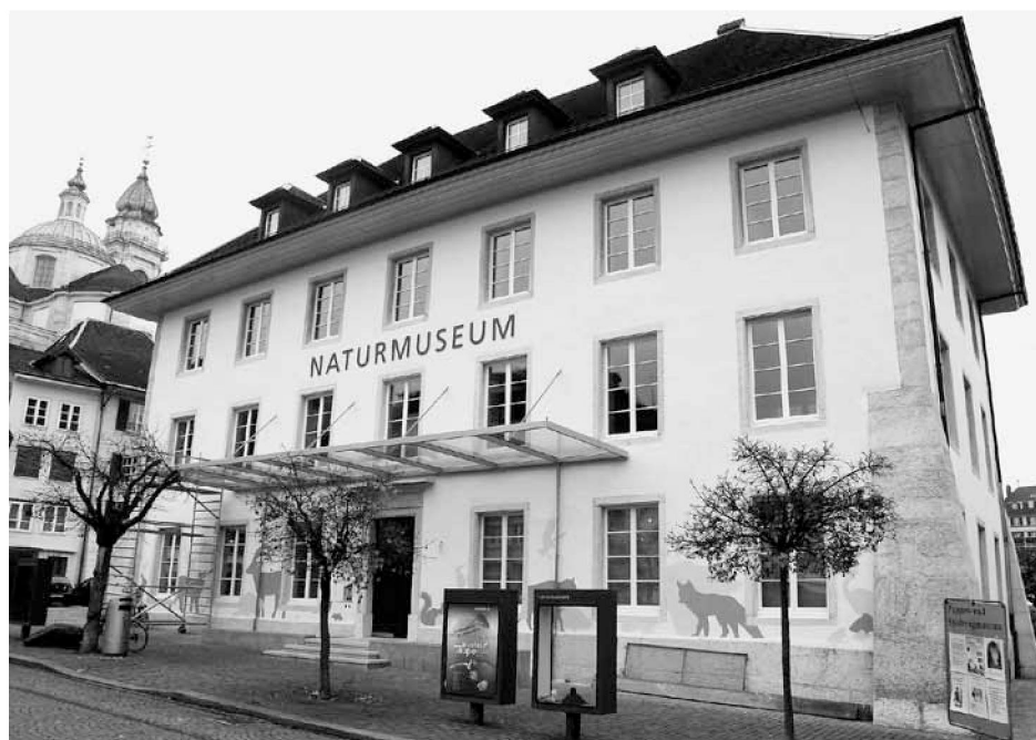
Frisches Erscheinungsbild des Museums auch von aussen: renovierte Fassade mit neuen Fenstern und Glas-Vordach.
