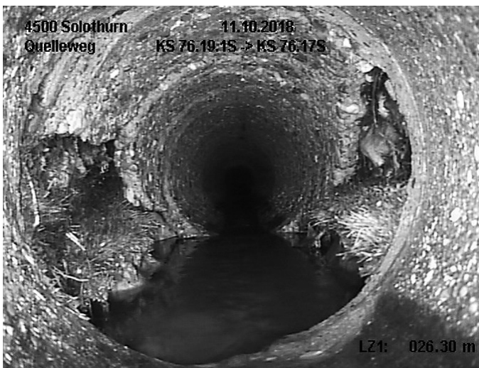
Kanalisation Quellenweg vor Sanierung.
