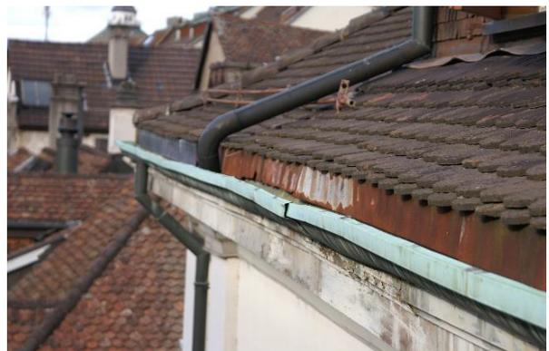
Deformierte und korrodierte Spenglerabschlüsse
