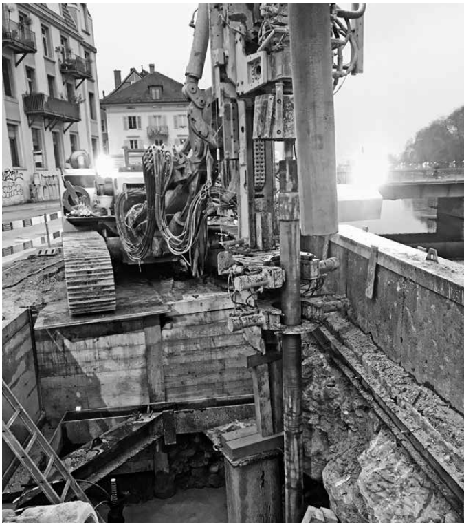
Pfahlfundamente Aaresteg; Foto Emch + Berger AG
