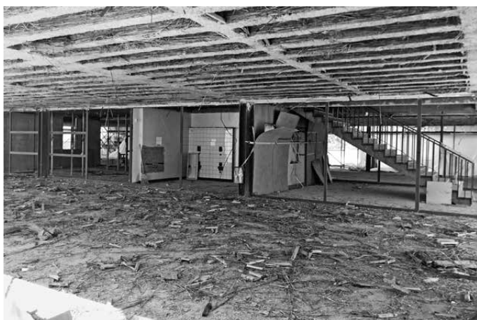
Wildbach Rückbau EG Klassentrakt
