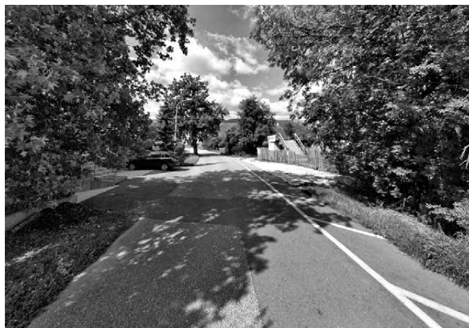
Erneuerung Brühlgrabenstrasse vor der Sanierung; Quelle Street Smart
