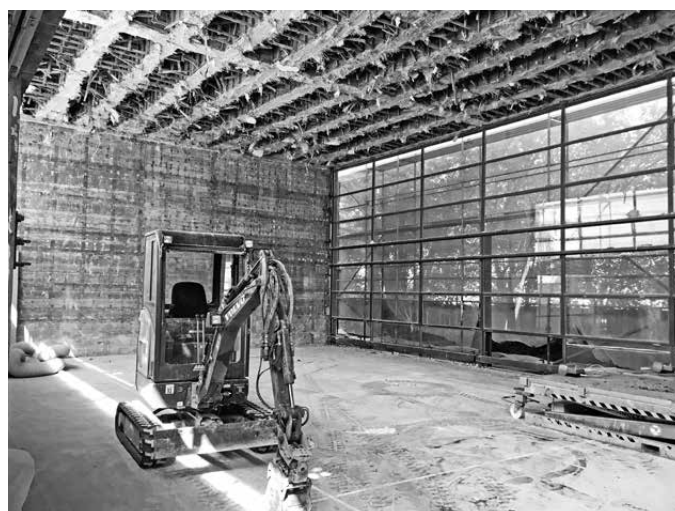
Wildbach Rückbau EG Turnhalle
