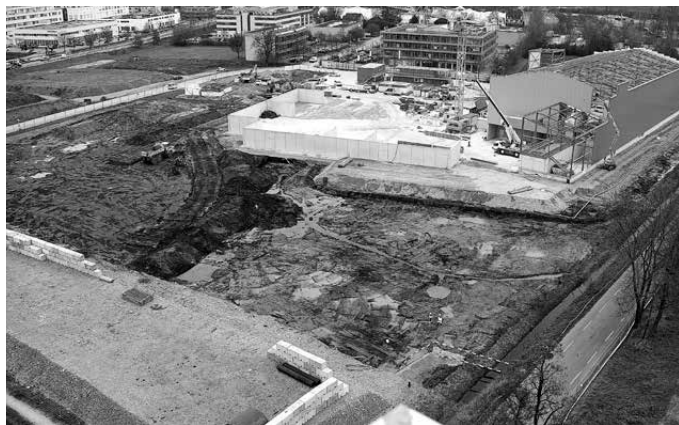
Sanierung Stadtmist Solothurn, Aufbereitungshalle im Aufbau; Quelle Amt für Umwelt Kanton Solothurn
