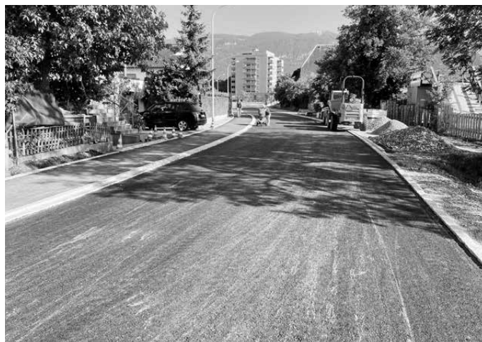
Erneuerung Brühlgrabenstrasse nach der Sanierung; Foto Stadtbauamt, Tiefbau
