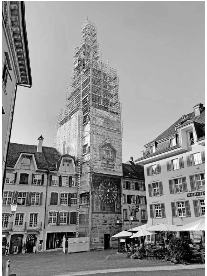
Zytgloggeturm Fassadengerüst
