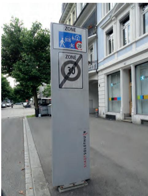
Abbildung: Signalisation mit Stele beim Übergang von einer Tempo 30 Zone in eine Begegnungszone, hier ausserhalb der Fahrbahn platziert.
