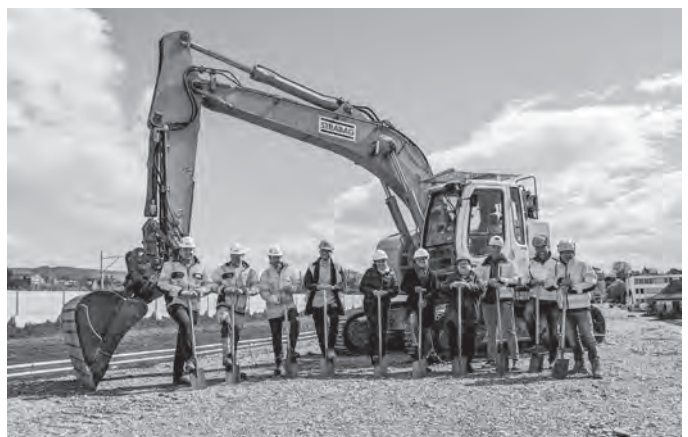
Weitblick Süd, Spatenstich Brühlhofpromenade; Foto Stadtbauamt, Tiefbau
