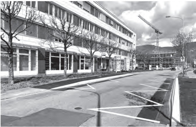
Bushaltestelle Casablanca; Foto Stadtbauamt, Tiefbau
