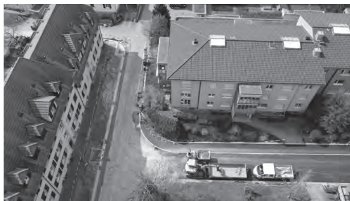
Strassensanierung Geissfluh- und Hasenmattstrasse; Foto W + H AG
