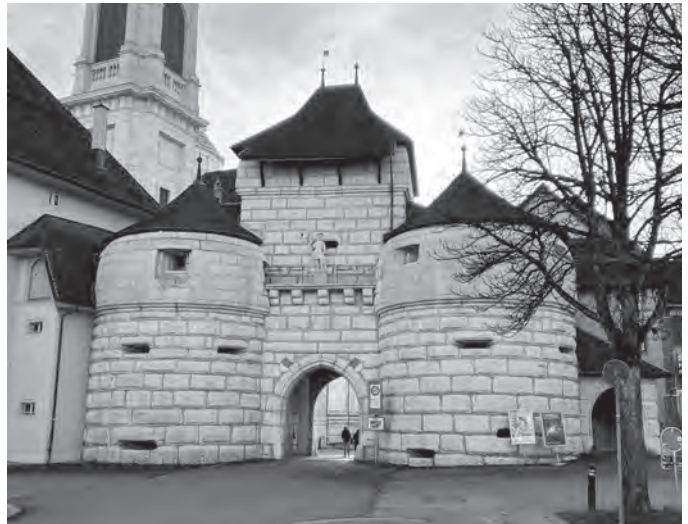
Baseltor Fassade Ost saniert
