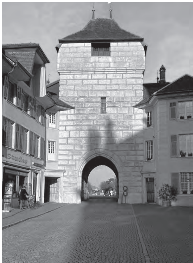
Baseltor Fassade West saniert
