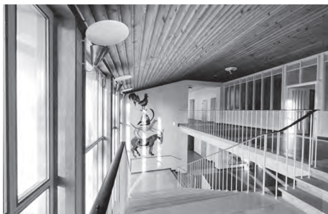
SH Vorstadt Schultrakt Treppenhaus
