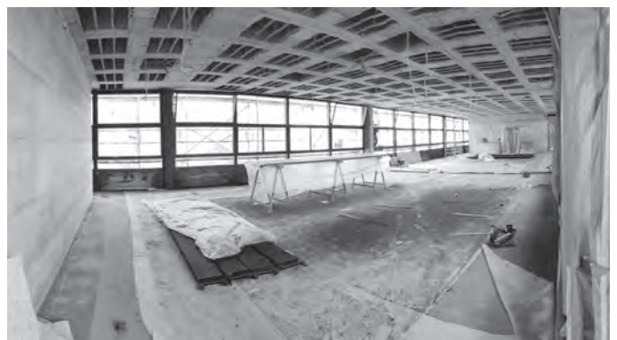
Impressionen aus der Sanierungsphase
