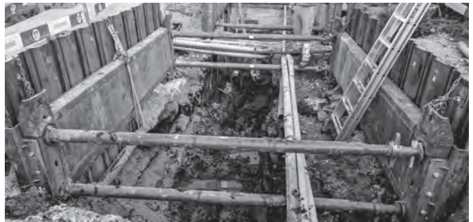
Leitungserneuerung Schmutz- und Regenwasserleitung; Foto Stadtbauamt, Tiefbau
