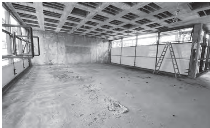
SH Fegetz Rückbau
