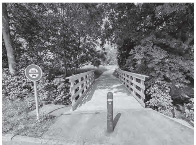
Neue Brücke Rehweg; Foto Stadtbauamt, Tiefbau
