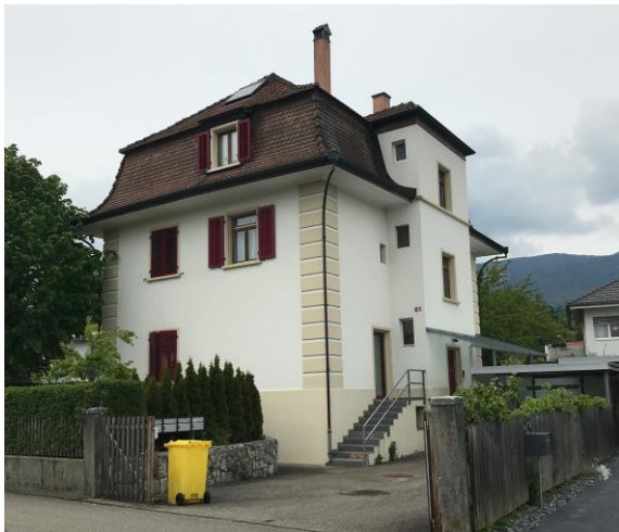
Abbildung 12: Besenvalstrasse 61 mit Hochparterre und Mansarddach
