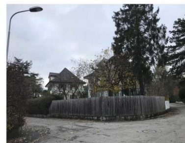
Ansicht ab Wedelswilstrasse, St. Niklausstrasse 54, 60
