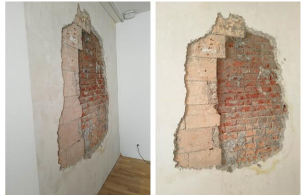
Freigelegtes Mauerwerk zur Austrocknung
