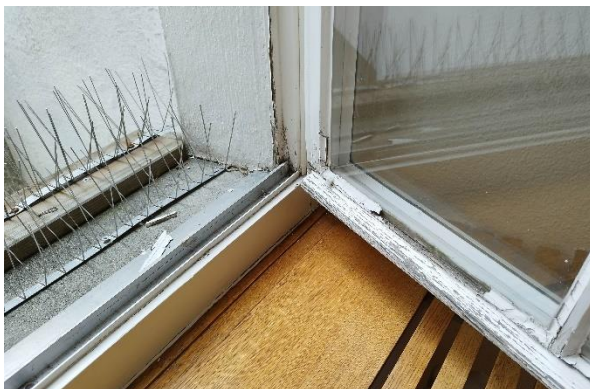
Morsche Holzteile, abblätternde Farbschicht, spröde Kittfugen
