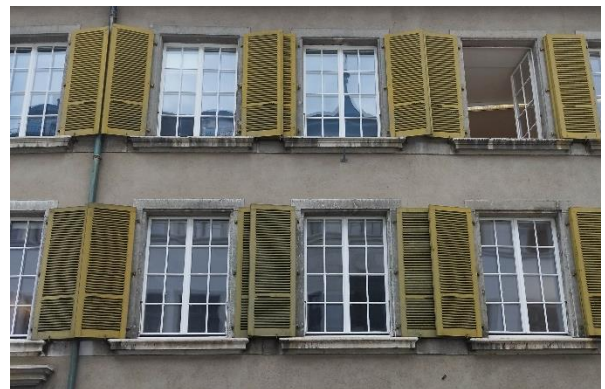
Morsche Holzteile, abblätternde Farbschicht, spröde Kittfugen
