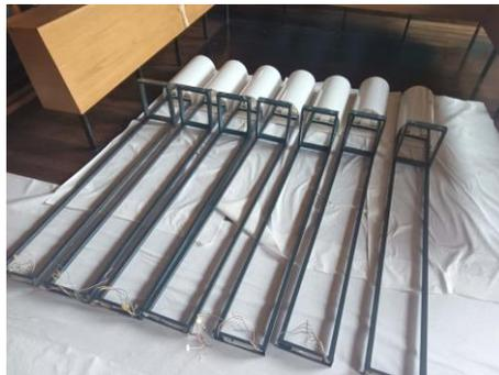
Die bestehende Beleuchtung wird demontiert und auf LED umgerüstet.
