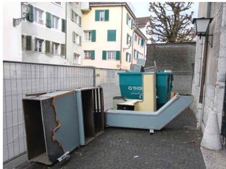
Die bestehenden Lüftungskanäle werden demontiert und entsorgt.
