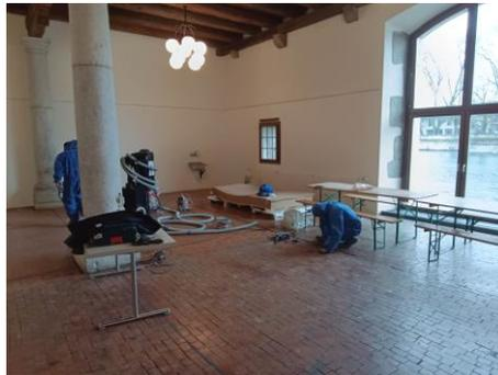
Die Lampen im Landhaussaal werden demontiert und die asbesthaltige Brandschutzverkleidung entfernt.
