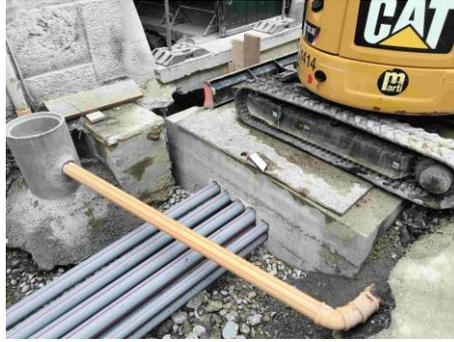
Der neue Elektroschacht vor der Trafostation wird betoniert.
