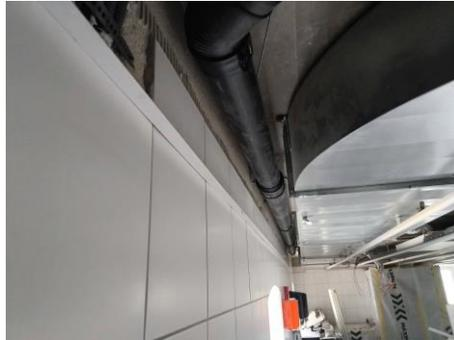
Die neuen Nasszellen und die entsprechenden Abwasserleitungen werden installiert.
