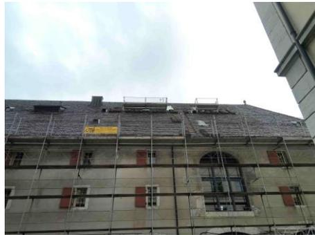
Im Bereich der Einbringöffnung werden die Dachziegel abgedeckt und Geländer eingerichtet.
