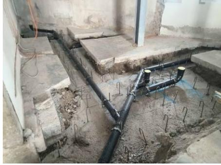
Im Erdgeschoss wird ein neuer Kanalisationsschacht und neue Kanalisationsleitungen installiert.
