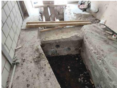
Die Gebäudeeinführung für die Elektroleitungen wird erstellt.
