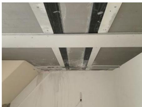
Im Dachgeschoss werden Lastverteilträger montiert.
