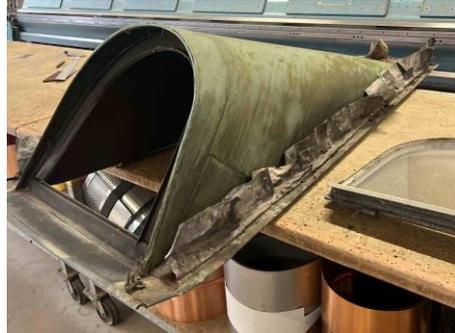
Eine bestehende Dachgaube wurde demontiert und der Zustand wird untersucht.
