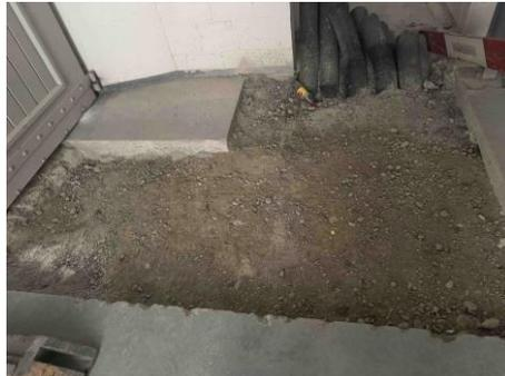
Der Elektroschacht wurde überdeckt und die Gebäudeeinführung aufgefüllt.
