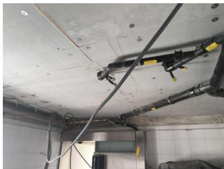
Die statischen Massnahmen an Träger und Decken werden brandschutzverkleidet.
