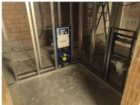
Die Kanalisationsleitungen im Erdgeschoss werden aufgefüllt. Die neuen Nasszellen werden installiert.
