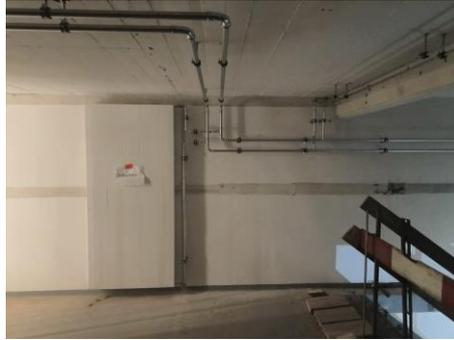
Die Fernwärmeleitungen und die Heizverteilung werden montiert.
