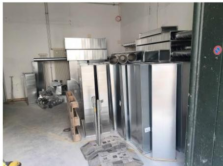
Die Monoblöcke und die Lüftungskanäle werden angeliefert.
