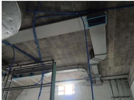
In der Nasszelle werden die Fortluftkanäle zum Landhaussaal montiert.
