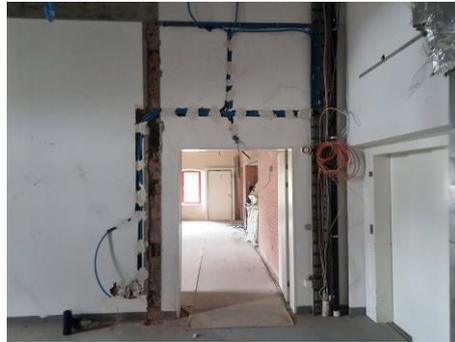
Die Elektrorrohre an der Landhausdecke werden montiert.
