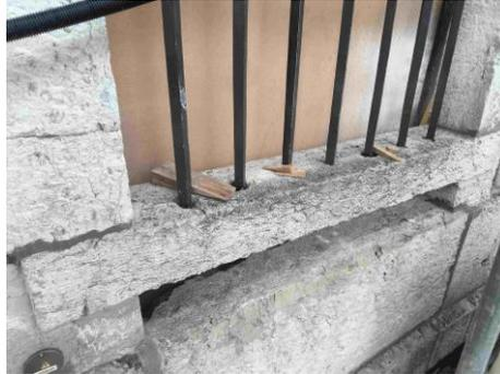
Die Gitterstäbe beim neuen Fenster werden montiert.
