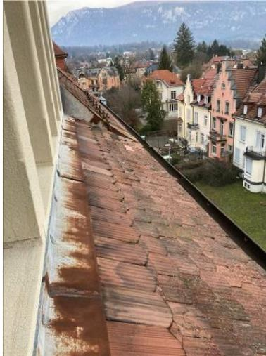
Deformierte, korrodierte Bleche
