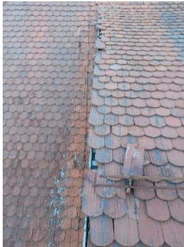
fehlende Dachziegel
