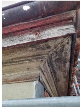
verfaulte Holzabschlüsse
