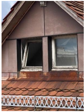
verfaulte Holzabschlüsse
