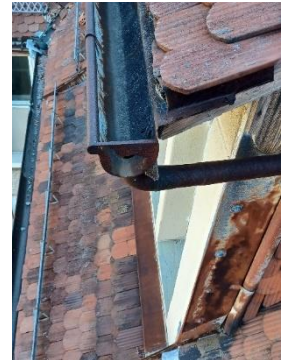
korrodierte Abschlussbleche
