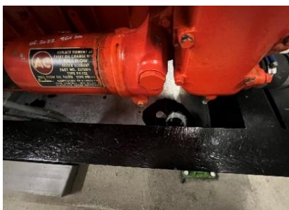
Leckendes Notstromaggregat
