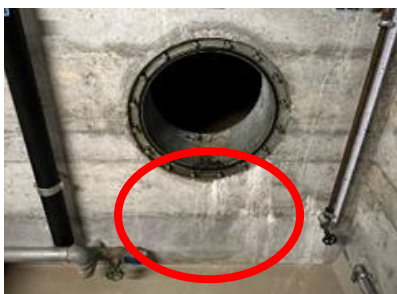
ein undichter, bestehender Wassertank
