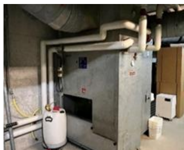
Bestehende Frischluftfilterbatterie
