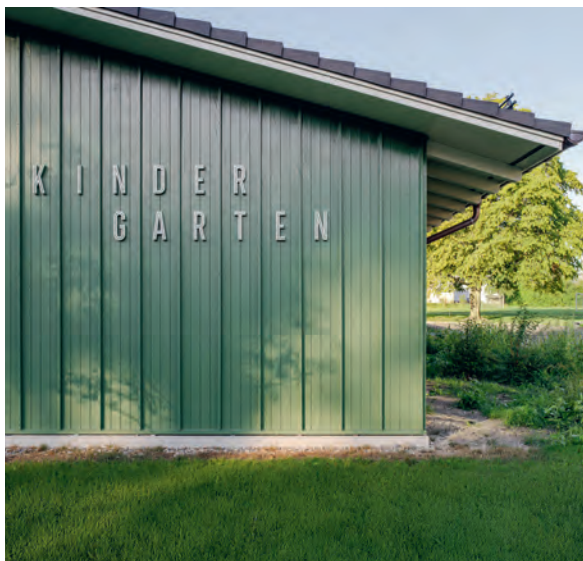
links: Ansicht von Norden und Signalistik am Neubau
