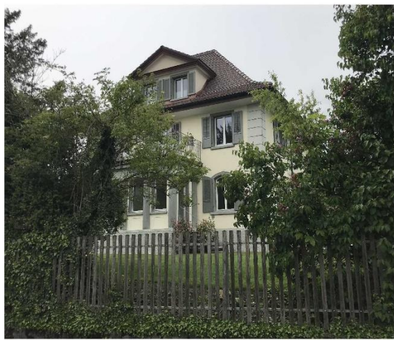
Abbildung 13: St. Niklausstrasse 54 mit Walmdach
