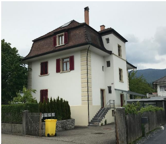
Abbildung 12: Besenvalstrasse 61 mit Hochparterre und Mansarddach
