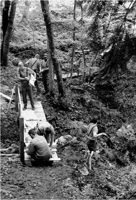
Brückenbau im Jura.
