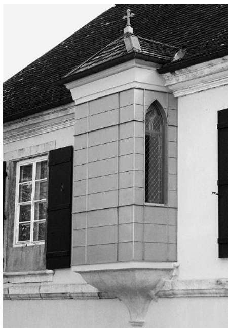
Erker aussen, saniert.
