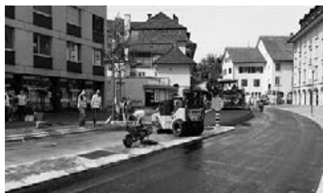
Deckbelagsarbeiten im Bereich Rossmarktplatz.
