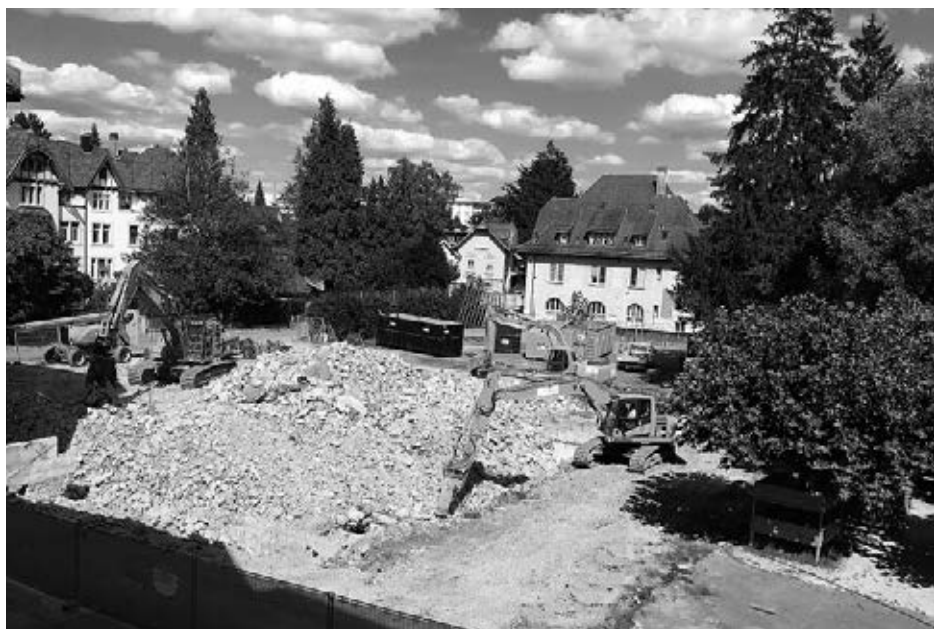
Die kläglichen Überreste der Turnhalle mit dem Installationsplatz.
