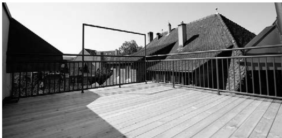
Kaiserhaus, Terrasse nach Sanierung.
