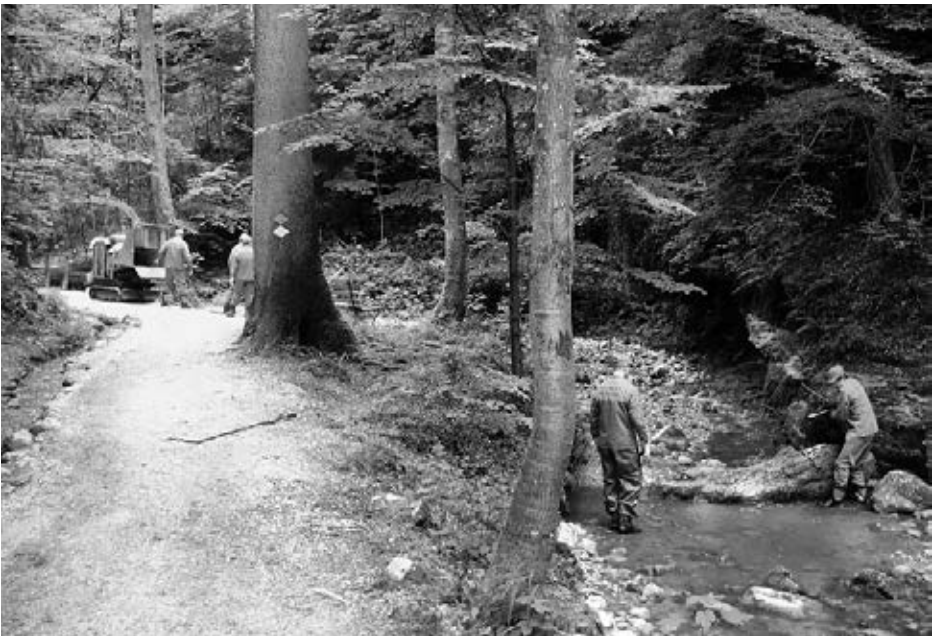
Instandstellung in der Verenaschlucht.
