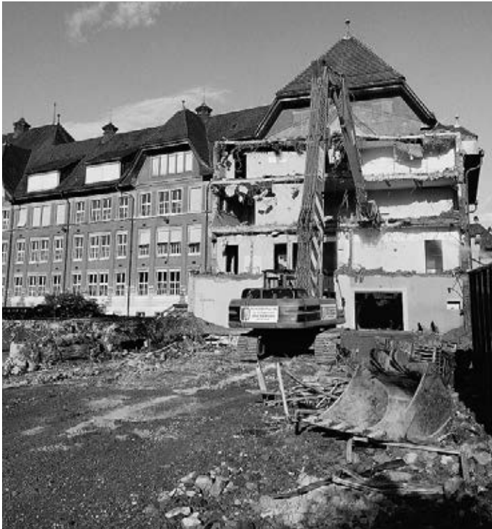
Für den Abbruch der alten Turnhalle wird schweres Geschütz aufgeföhren.
