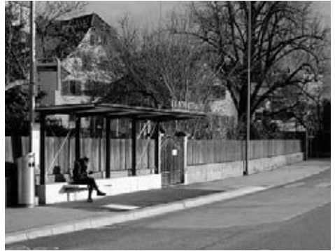
Buswartehäuschen Grenchenstrasse Nord.
