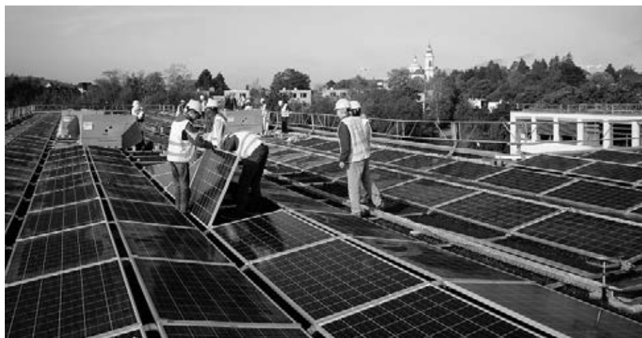
Schützenmatt, Montage Photovoltaik.
