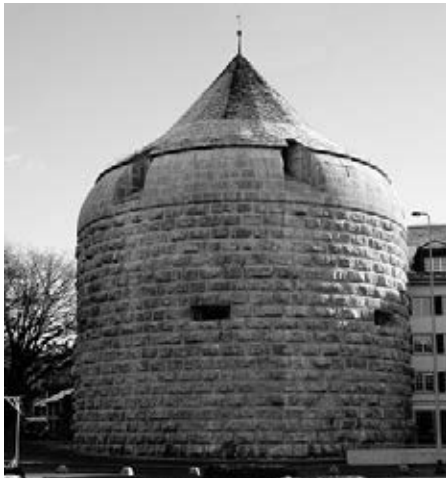
Burrsturm nach der Sanierung.
