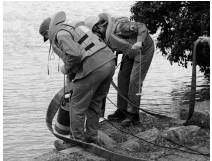
Einsatz einer Tauchpumpe.
