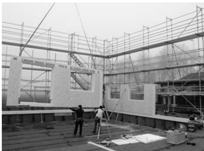
Neubau Garderobenpavillon Elementmontage Zimmermann.
