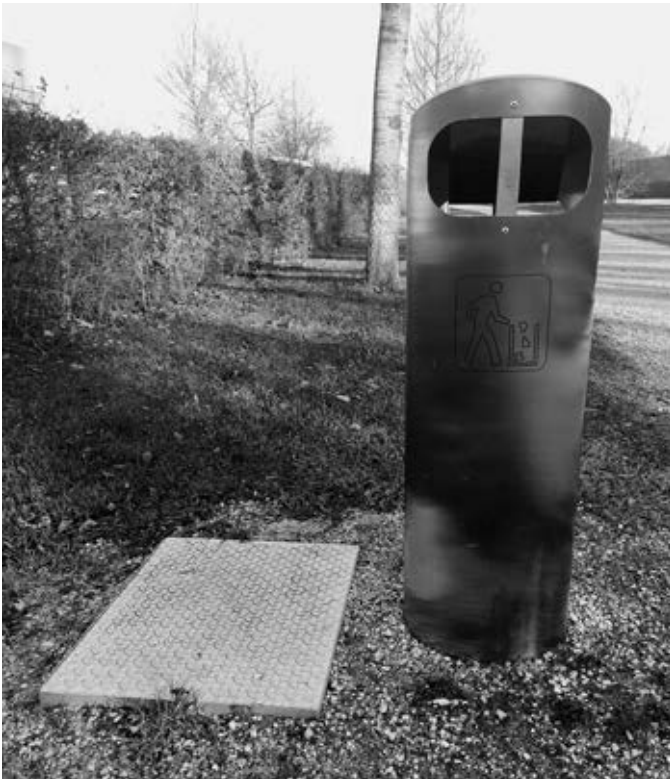
Unterirdischer Kehrichtkübel.
