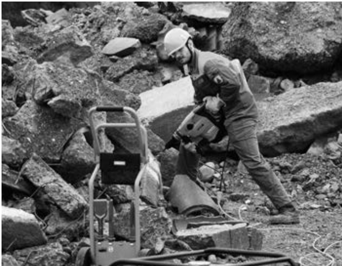
Arbeit mit dem Abbauhammer.
