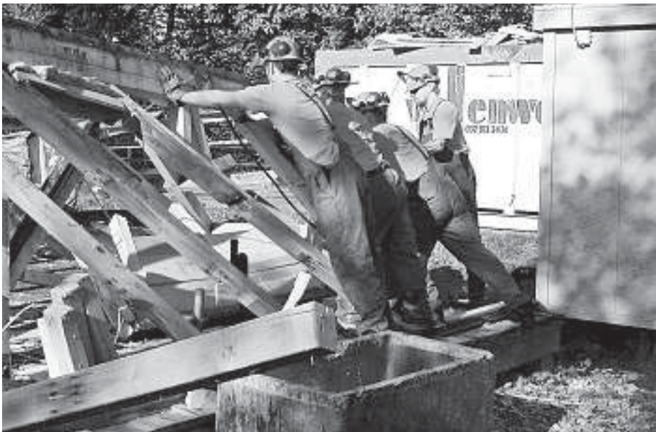
Handarbeit Abbruch Güggi.
