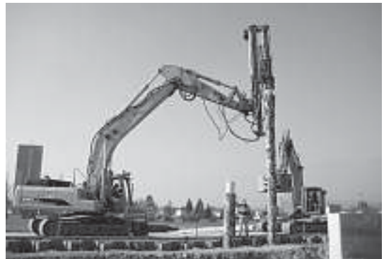
Pfählungsarbeiten Kanalisation Grabackerstrasse
