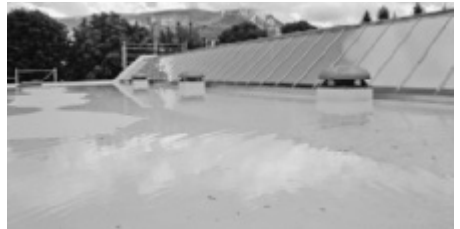
Saniertes Flachdach Schulhaus Schützenmatt.
