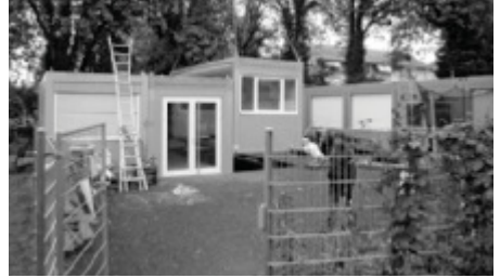
Spielplatz Güggi: Montage der Container.
