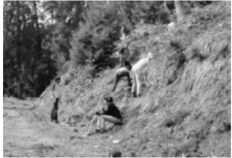
Die Arbeit im steilen Gelände ist hart und ungewohnt.
