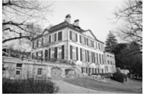
Sanierte Fassade von Südwesten.
