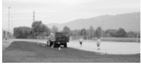
Einbau des Ricotenbelages.
