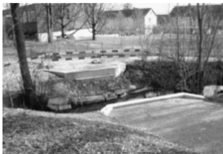
Vorbereite Widerlager für die neue Fussgängerbrücke über den Dürrbach.
