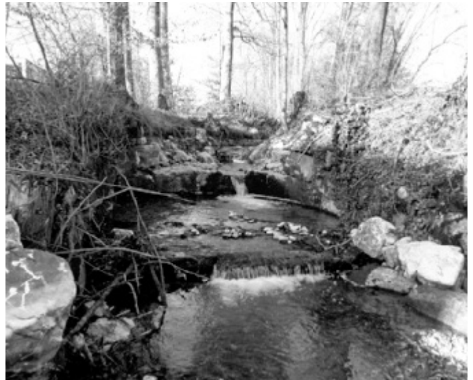
St. Katharinenbach nach der Sanierung
