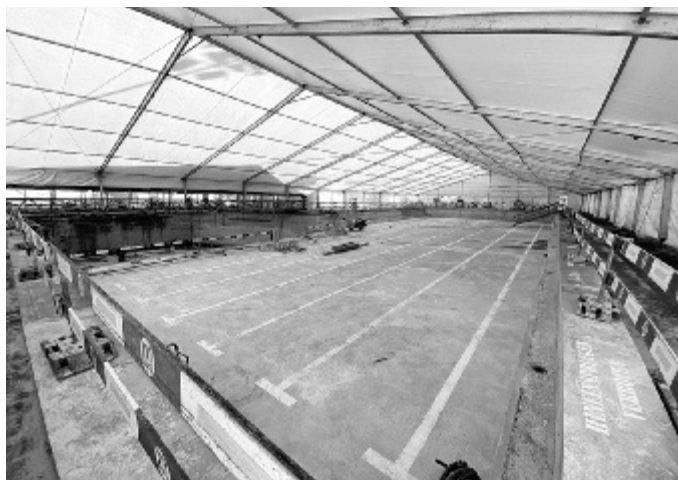
Freibad Sanierung Sportbecken.
