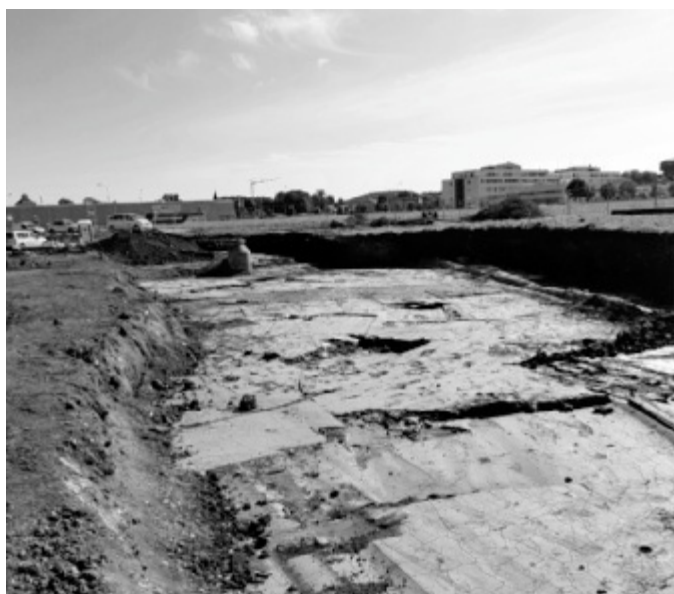
Aushub Altlasten im Bereich der künftigen Oberhofstrasse.
